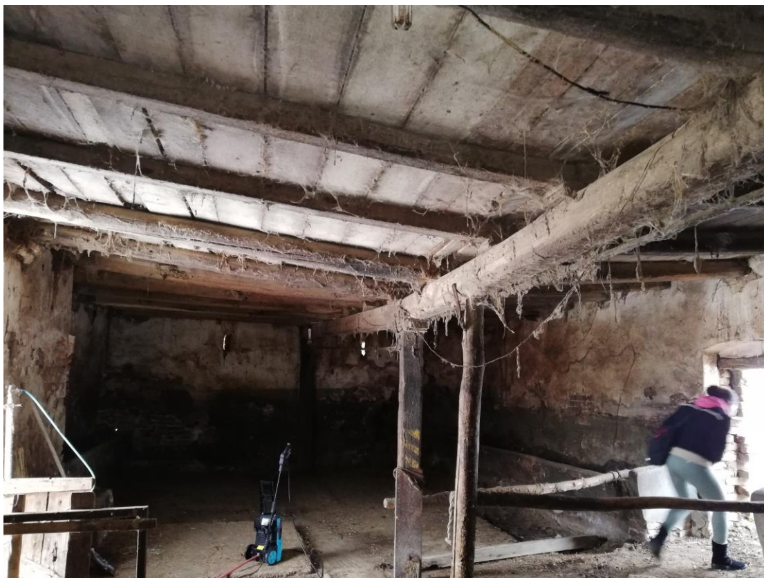
1. Gazdasági épület: födémszerkezet
