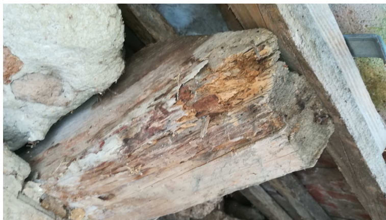
8. sz. kép : a kötőgerenda vége kb. 2-3 cm mélyen korhadt és rovarrágott is
