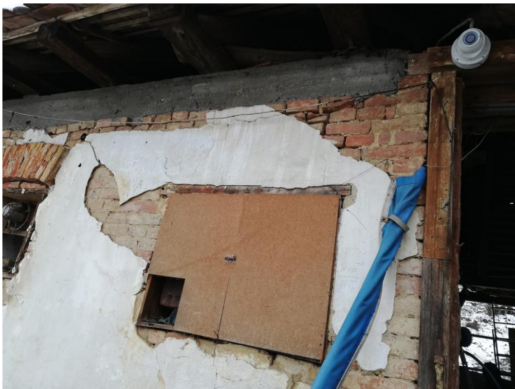
6. Gazdasági épület: homlokzati fal
