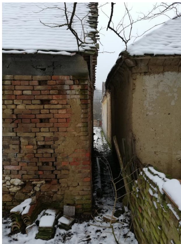
2. Gazdasági épület: végfal
