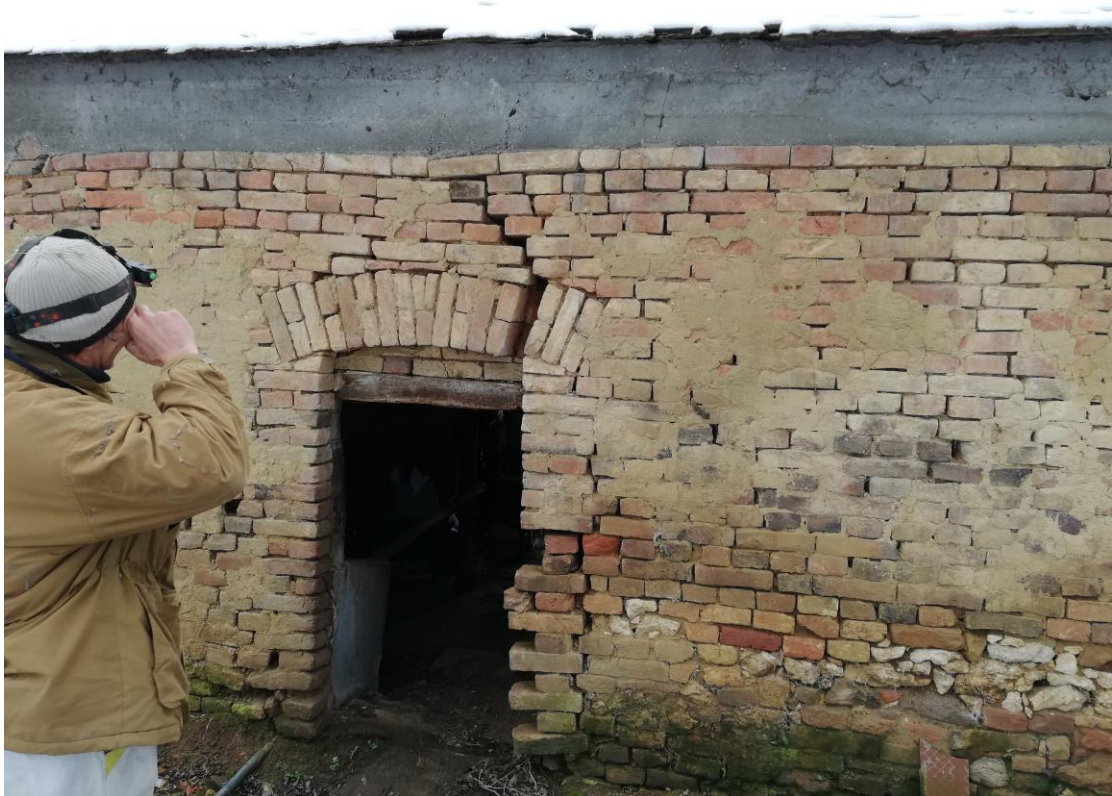
4. Gazdasági épület: homlokzati fal
