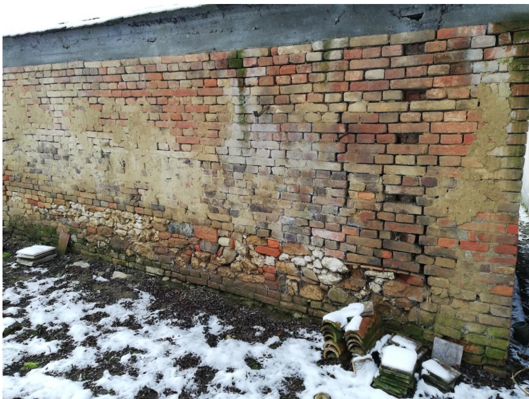
5. Gazdasági épület: homlokzati fal
