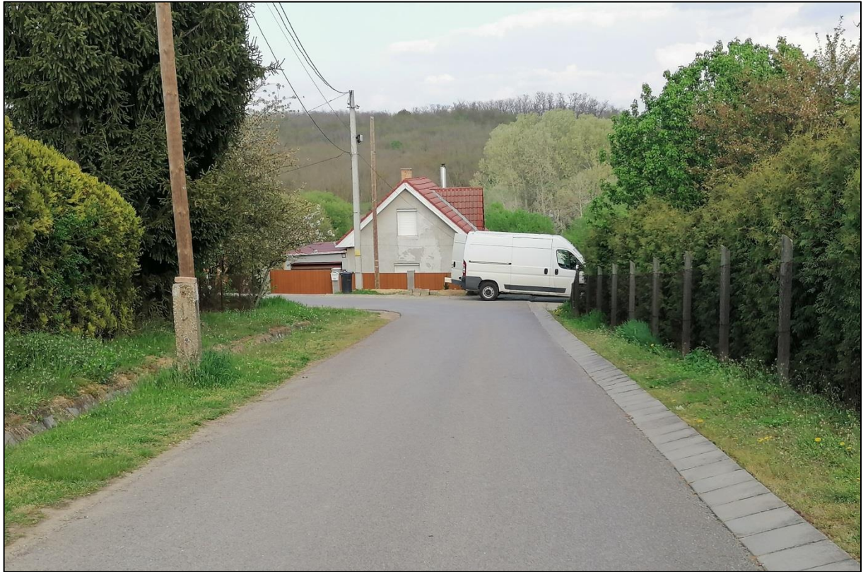
1. sz. fénykép: A Csikósvölgyi úti kis sugarú, nem megfelelően észlelhető ív
