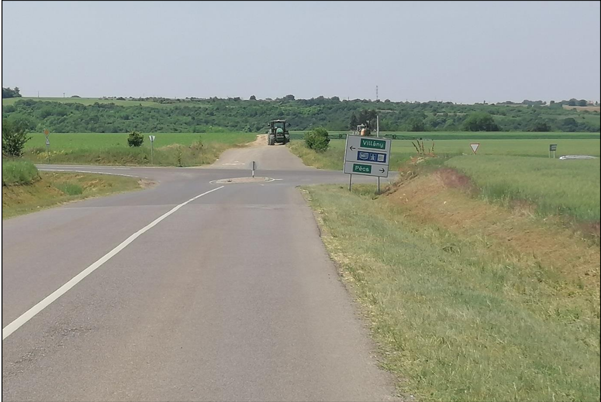
7. sz. fénykép: A József A. utca 578. sz. főúti csatlakozásában nem megfelelően észlelhető „Elsőbbségadás kötelező” jelzőtábla és forgalomterelő sziget
