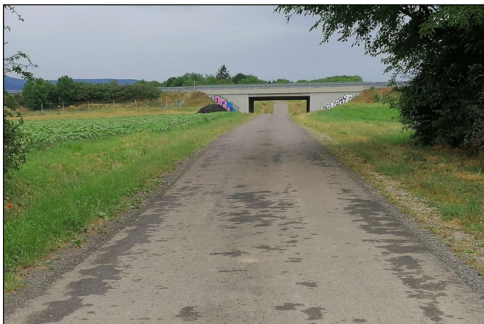
14. sz. fénykép: A régi temetőhöz vezető úton a magassági vonalvezetés miatti korlátozott látótávolság
