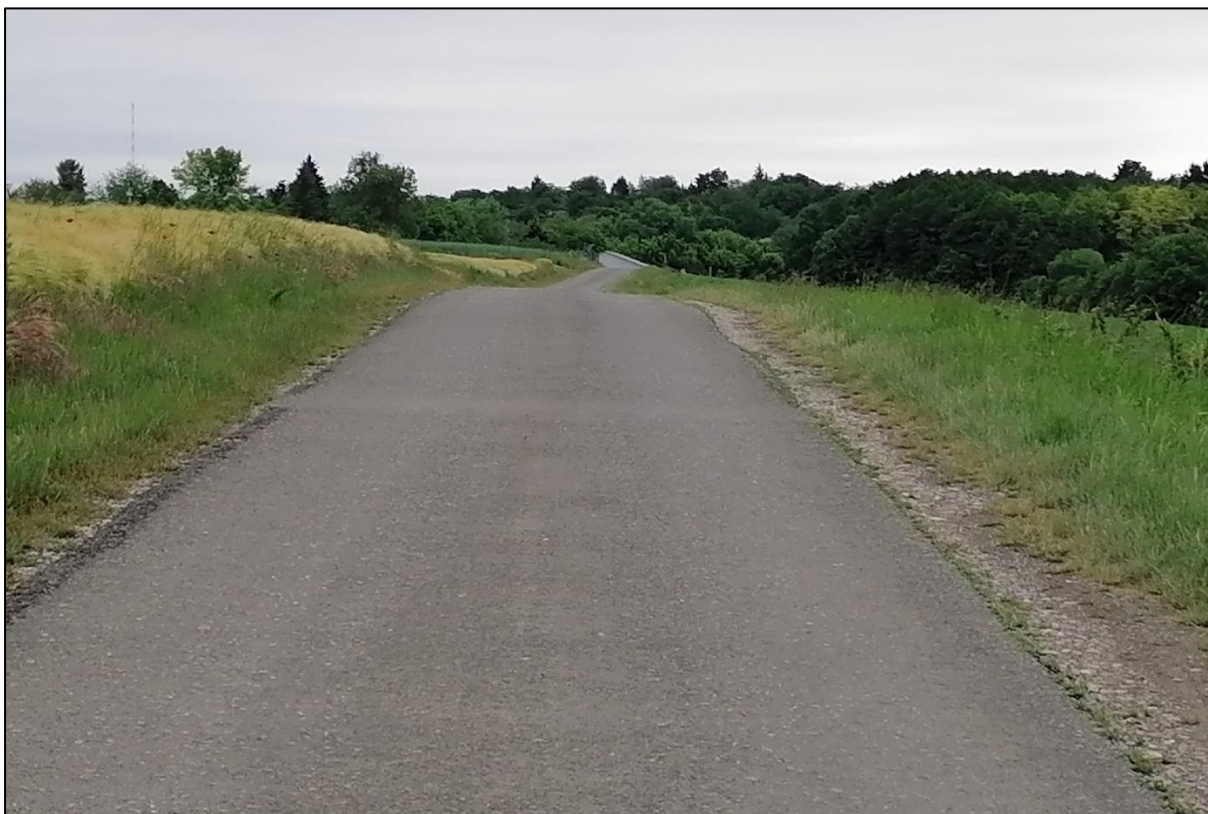
11. sz. fénykép: A horgásztó felé vezető úton a magassági vonalvezetés miatti korlátozott látótávolság
