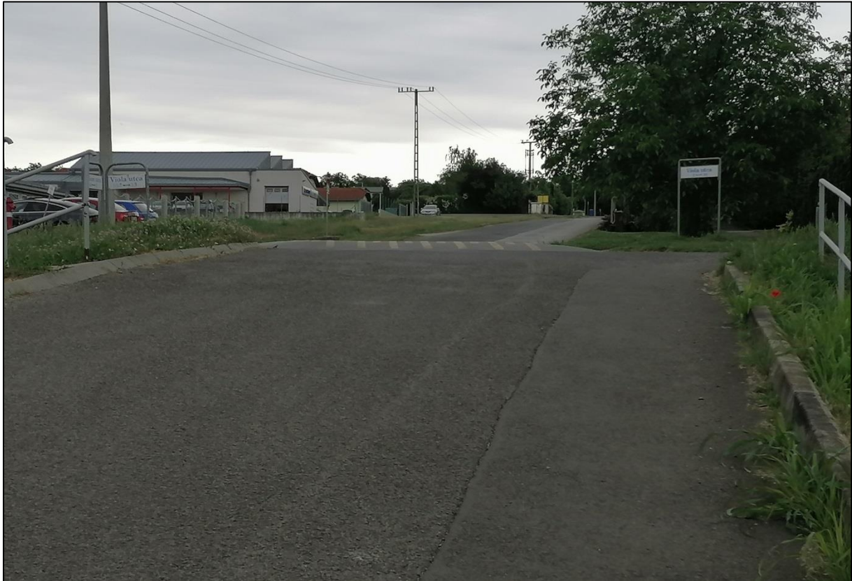
10. sz. fénykép: A Liliom utca és a Viola utca csatlakozásában lévő, nem megfelelően észlelhető burkolatmagasítás
