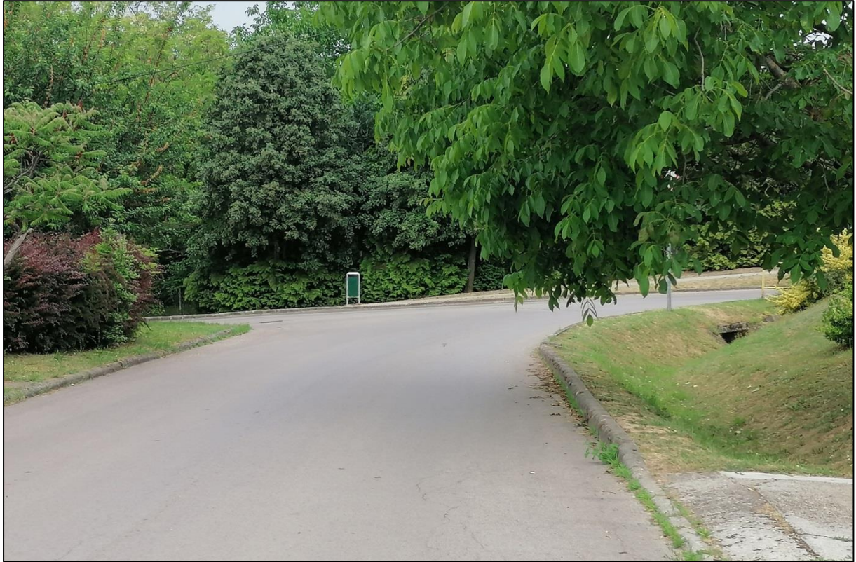
18. sz. fénykép: Az „Elsőbbségadás kötelező” jelzőtábla nem megfelelő észlelhetősége a Széchényi utcai csatlakozásban
