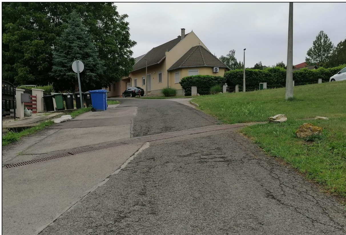
22. sz. fénykép: A Jácint utca csatlakozásában egyenrangú útkereszteződés és a Viola u. felől jelentős emelkedőn érkező alárendelt irány
