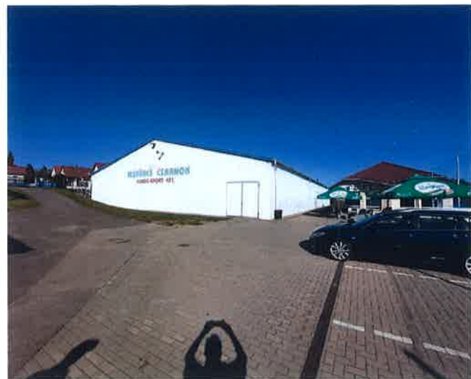
műfüves csarnok homlokzat
