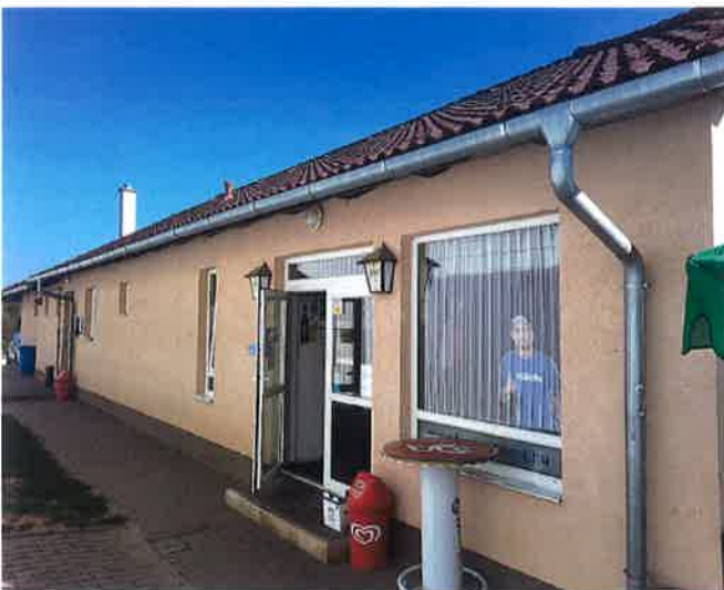
büfé-öltöző északi homlokzat
