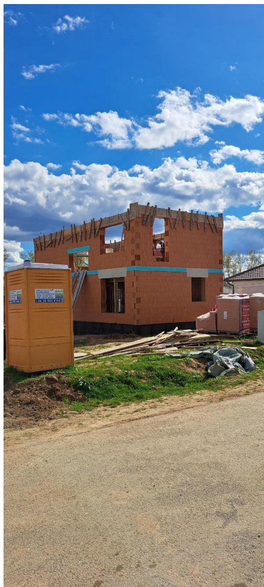
1. kép: A kétszintes épület továbbra is építkezés alatt áll. (Kép készült: 2024.03.25.)
